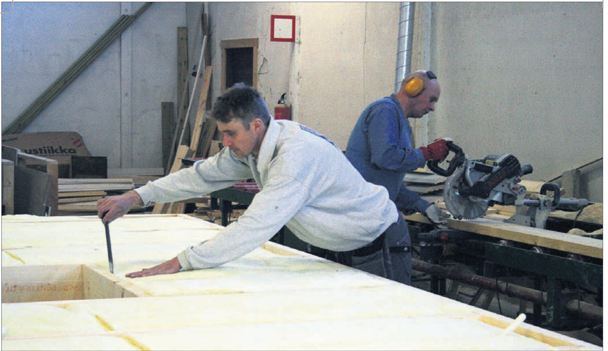
Johan Markén jämnar ut glasfiberisoleringen så att den ska bli lika tät överallt i väggen. Bakom står Kennet Hägg och kapar en bräda.
