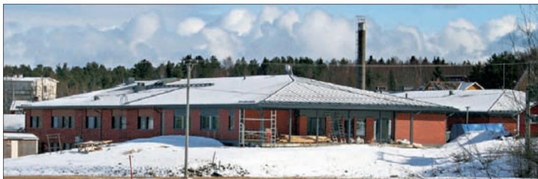
Hvc i Oravais får en ny bäddavdelning och den gamla grundrenoveras. I september ska allt vara klart.
