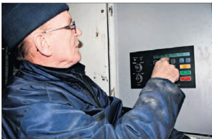
Bo-Göran Norrgård ser på mätartavlan som visar vindriktning, vindhastighet och hur mycket vindkraftverket producerar.
