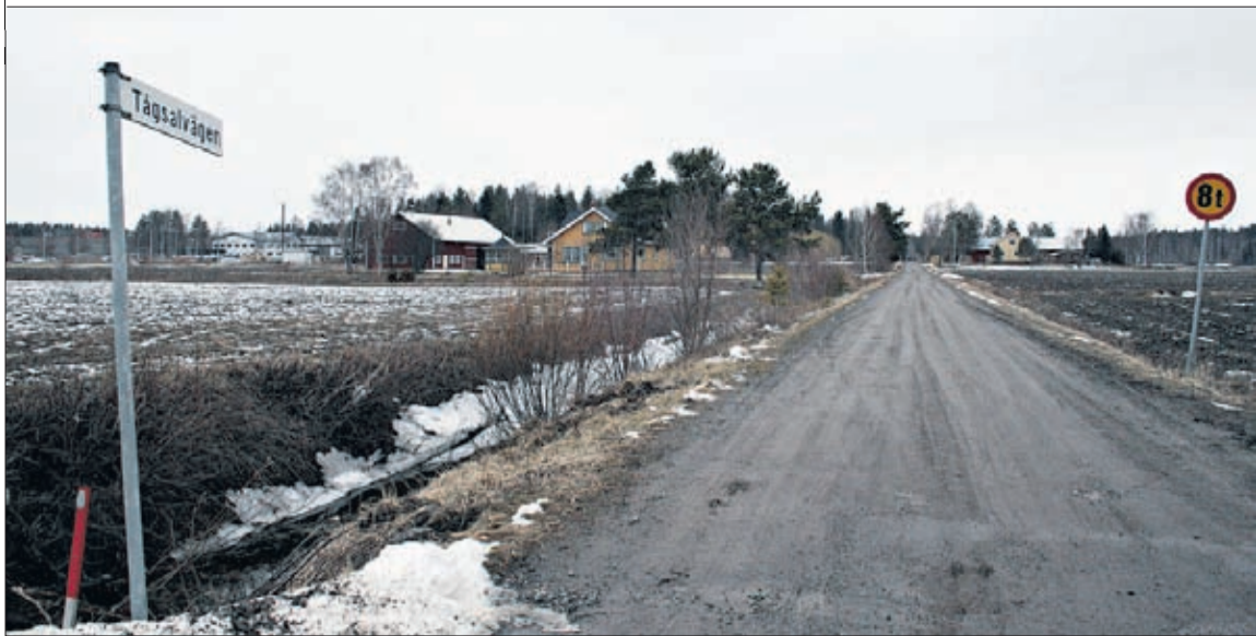
Breddningen och grundförbättringen av Tågsalvägen är det första steget när det gäller att bygga ut kommunaltekniken till det nya bostadsområdet i Vörå. Just nu begär kommunen in offerter på arbetet. Nyåkern ligger snett bakom industriområdet.
